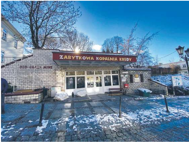
Wejście do Chełmskich Podziemi Kredowych przy ul. Lubelskiej będzie wyremontowane
