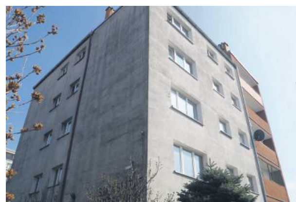
Blok przy ulicy Książąt Brzeskich 6 w Strzelinie
