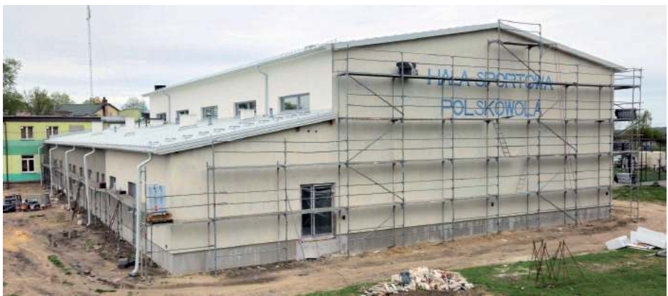
Kolejne postępy również przy budowanych halach sportowych. W ubiegłym tygodniu wójt Anna Mróz oraz dyrektorki szkół w Polskowie i Turowie wybrały kolory nawierzchni w poszczególnych obiektach
