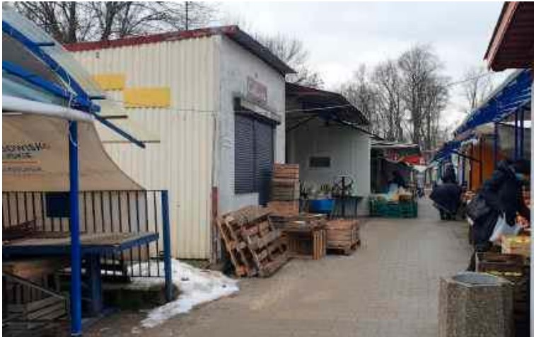
Miasto przy okazji przebudowy targu chciałoby odkupić od kupców i zmodernizować pawilony od strony ul. Okulickiego
