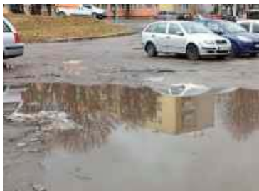
Olbrzymie kałuże, które tworzą się wzdłuż budynku przy ul. Kosynierów 10 są utrudnieniem klientów sklepów „Ziarenko” i „Premium”
