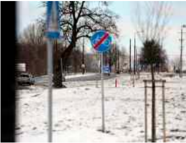
Nowe chodniki i ścieżka rowerowa przy ul. Franczaka „Lalka” mają być gotowe już w połowie tego roku
