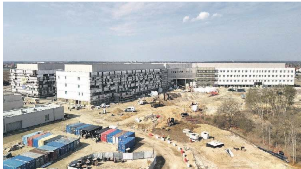
Budowa Nowego Szpitala Onkologicznego idzie pełną parą
