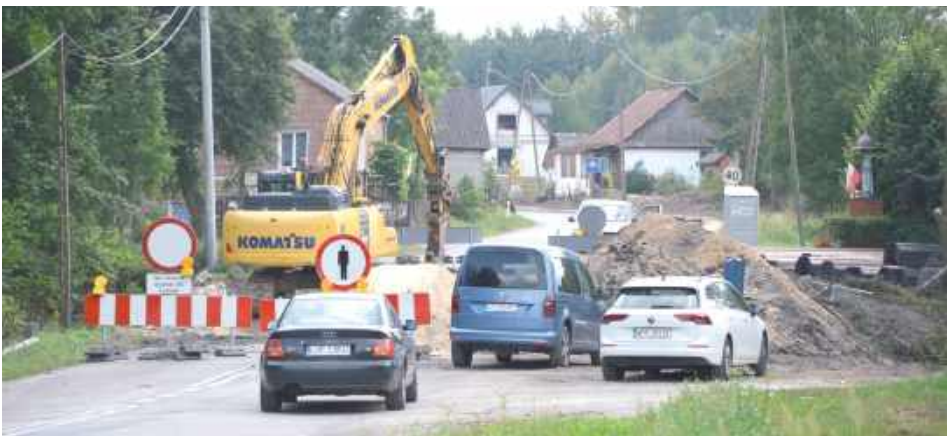
W Godowie rozpoczęła się rozbiorka istniejącego mostu. W jego miejsce posadowiony zostanie nowy, odtworzona istniejąca konstrukcja drogi i wybudowany ciąg pieszo-jezdny
