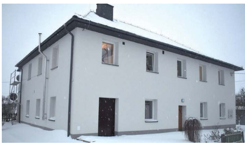
W Domu Nauczyciela w Biszczu wymieniono między innymi dach, okna, drzwi oraz wykonano termomodernizację ścian, docieplenie i nową elewację
