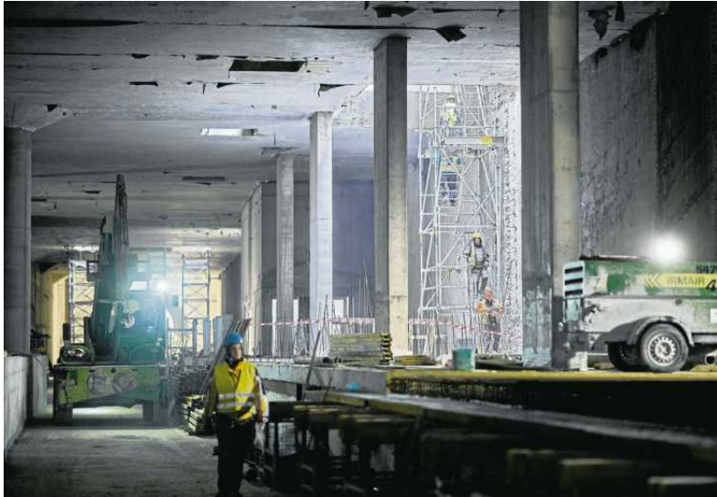
• Budowa tunelu średnicowego i podziemnej stacji kolejowej Łódź – Koziny FOT. TOMASZ STAŃCZAK / AGENCJA WYBORCZA.PL
