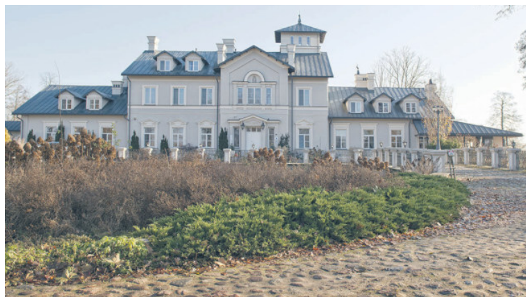
Pałac w Trojanowie
