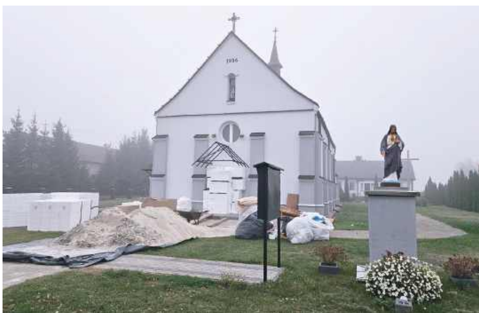
Trwają już prace przy zabytkowym kościele pod wezwaniem Niepokalanego Poczęcia NMP w Kożuszach
