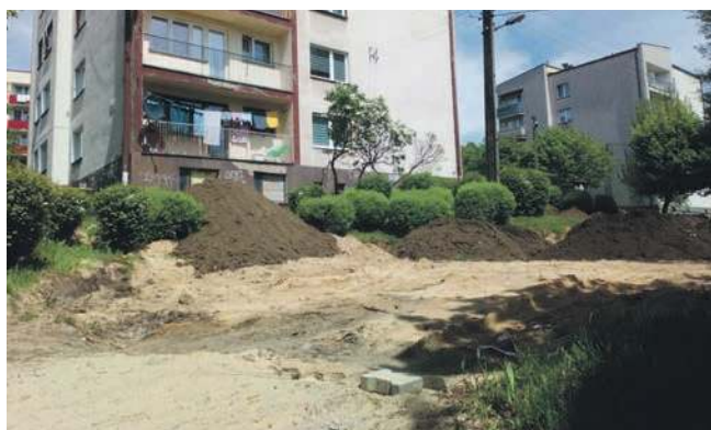
Urządzenia z placu zabaw zdemontowano i przystąpiono do niwelacji terenu
