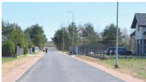
Nowa droga w gminie Puchaczów już gotowa
