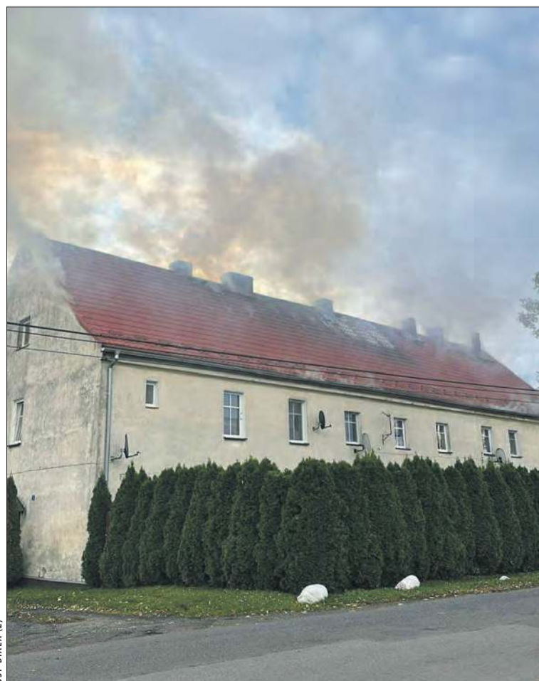
Ogień objął górną część budynku
