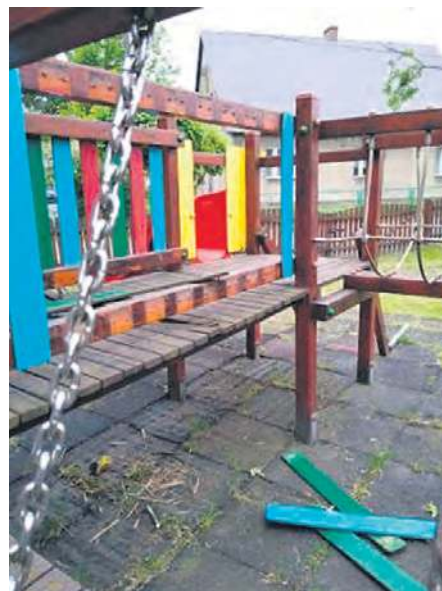
Potłamane szczelbelki, zniszczony pomost.
