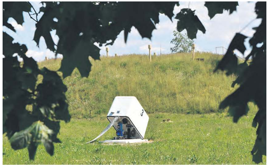
– Na studni nr 3 prowadzone były zaplanowane prace naprawcze. Czyściliśmy ją. Zapewniam, że w związku z tymi pracami nie ma żadnego zagrożenia dla mieszkańców. Studnia na ten moment nie podaje wody do sieci, przeprowadzamy płukania [...] – tłumaczy kierowniczka ZGK Justyna Banaszek-Turzyńska.
