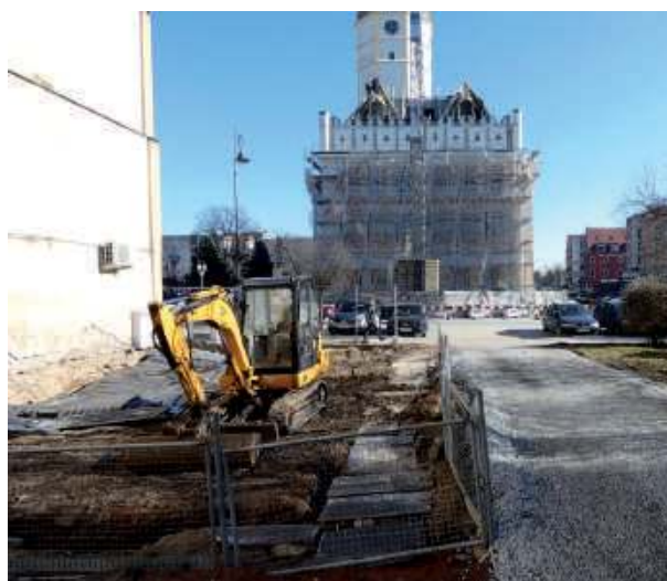
Prace ziemne już się zaczęły. Jak wszystko pójdzie dobrze, to obiekt zacznie rosnąć w oczach
