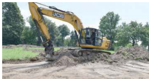
W Potoku Górnym trwa budowa nowej infrastruktury sportowej
