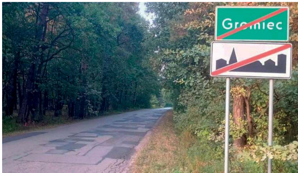
Duża część odcinka planowanego do remontu prowadzi przez las
