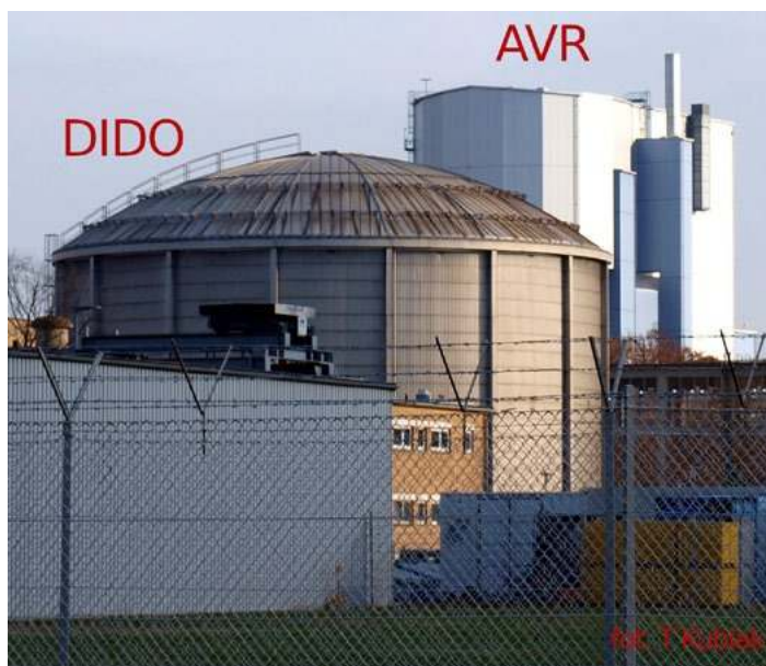
Fot. 1. Kopuła kryjąca zlikwidowany reaktor DIDO oraz budynek nieczynnego reaktora AVR.
