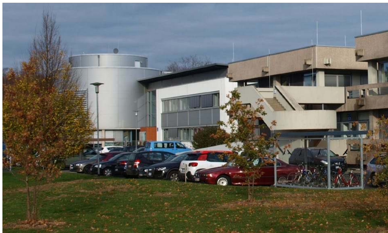
Fot. 5. Siedziba centrum superkomputerowego JSC.
