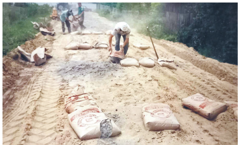
Tak przed laty budowano drogę w Kopciach
