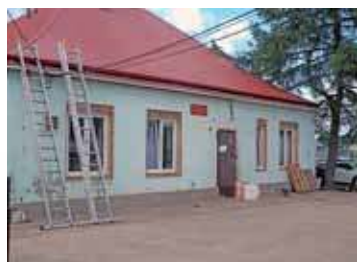
Trwa termomodernizacja budynków Urzędu Gminy i GOPS-u
