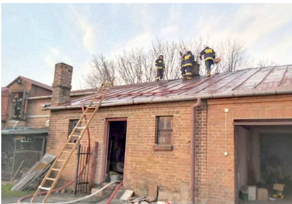
Ledwo strażacy wrócili do bazy, znów zawyły syreny - palił się dach budynku w Grądach
