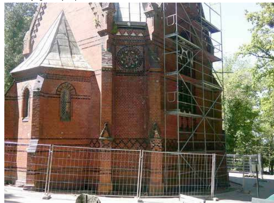
Kaplica w remoncie
