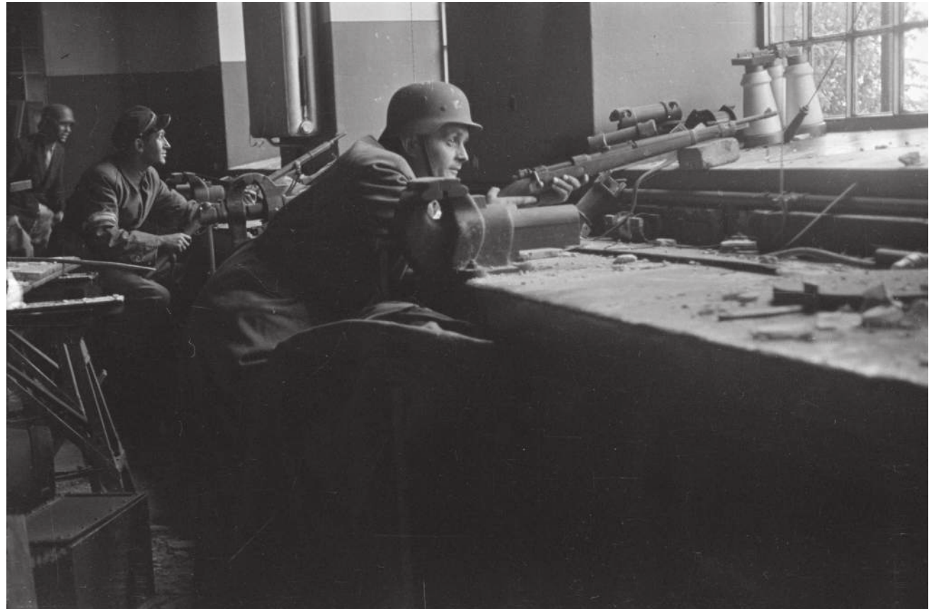
W jednym z warsztatów w budynku technicznym zostało zorganizowane stanowisko strzeleckie. Na pierwszym planie widoczny ppor. Feliks Wodzyński „Semek” (z karabinem Mauser), a dalej ppor. Wincenty Szantyr „Ursyn”
