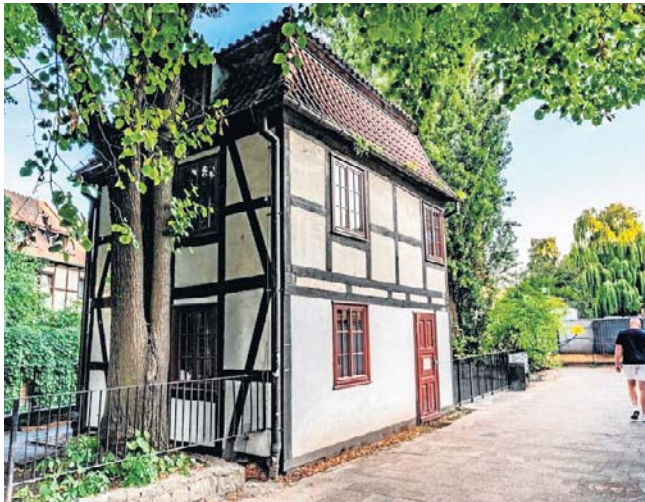
Budynek z przełomu XVIII/XIX wieku przy ul. Wodopój 7 w Gdańsku. Powstanie tutaj kawiarnia
