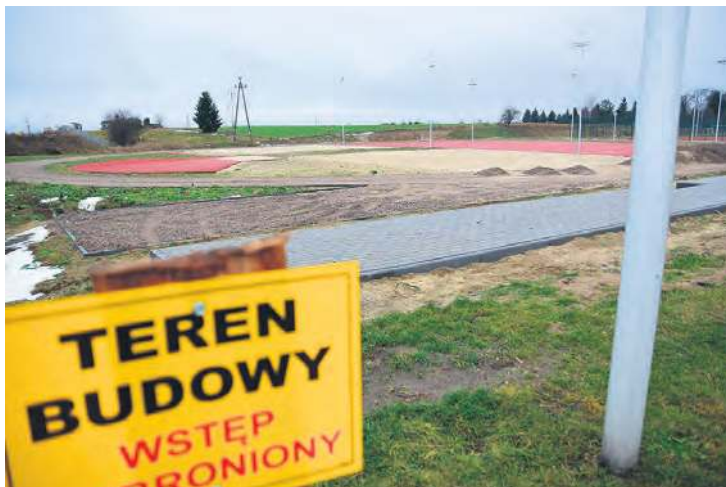
W tym roku zakończona ma być budowa kompleksu boisk sportowych, bieżni lekkoatletycznej oraz zaplecza socjalnego na działce obok Szkoły Podstawowej w Cekcynie (dawnego gimnazjum) i przedszkola.
