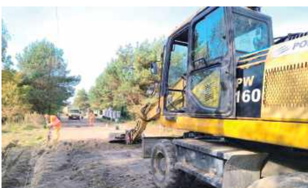
Remont drogi w Puchaczowie
