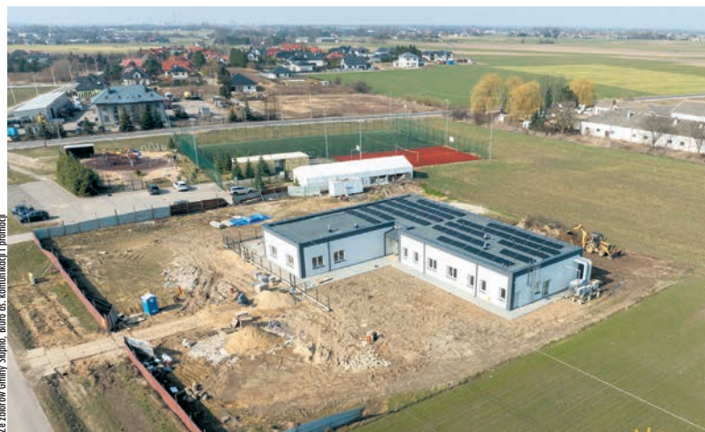
Budowa Centrum Opiekuńczo-Mieszkalnego w Starym Gulczewie
