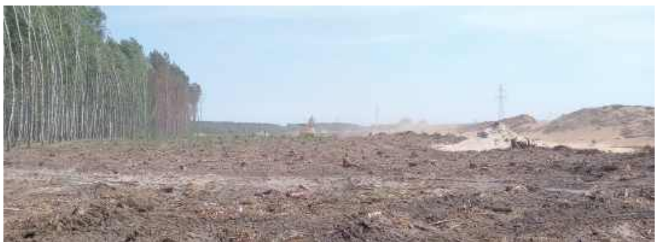
W okolicach Dobrynia trwa już przygotowanie terenu
