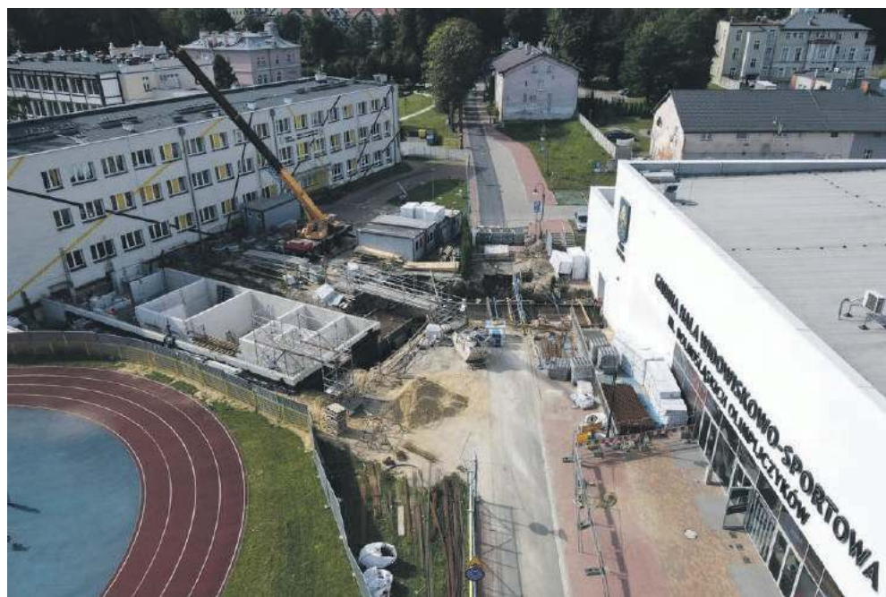
Przy hali budowane jest nowe skrzydło szkoły
