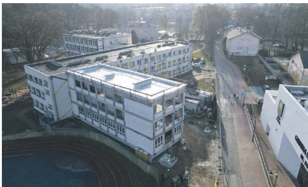
Prace ziemne nad nowym łącznikiem już zakończono
