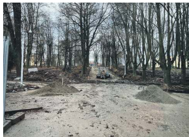
Tak wyglądał park w dniu 13 stycznia tego roku. Jak widać jest rozkopany i o końca remontu jest daleko
