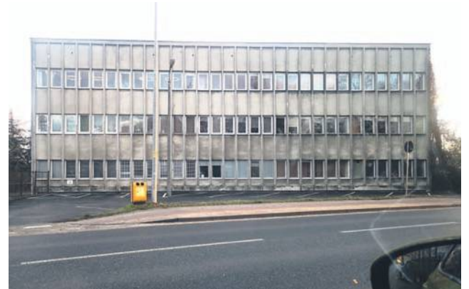
Zakład Wodociągów i Kanalizacji
