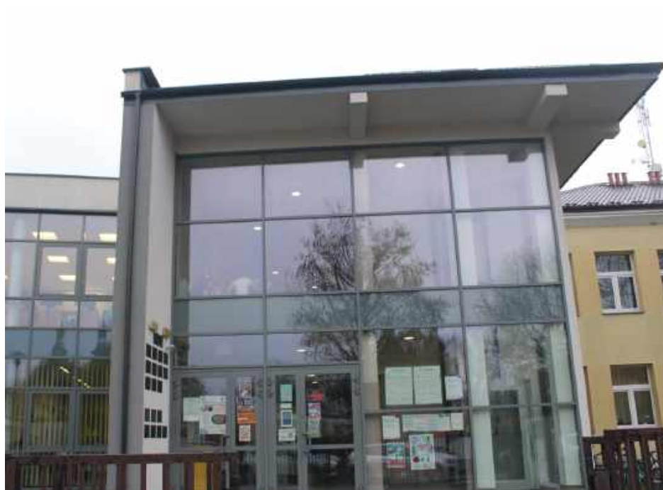
Dobudowa w 2018 r. nowa część szkoły z pozoru wydaje się nowoczesnym obiektem na miarę XXI wieku. Niestety od środka sprawa wygląda zupełnie inaczej
