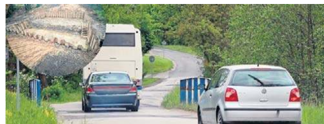
Zdezelowana Wadowicka przechodzi remont
