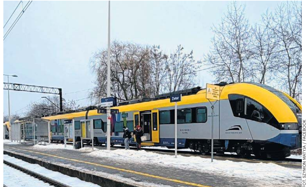
PKP Polskie Linie Kolejowe przebudują w tym roku stację kolejową w Zatorze. Dzięki inwestycji pociągi przyspieszą
