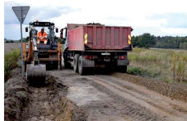
Sprzęt już pracuje. Droga nie tylko zyska nową nawierzchnię, ale zostanie również poszerzona
