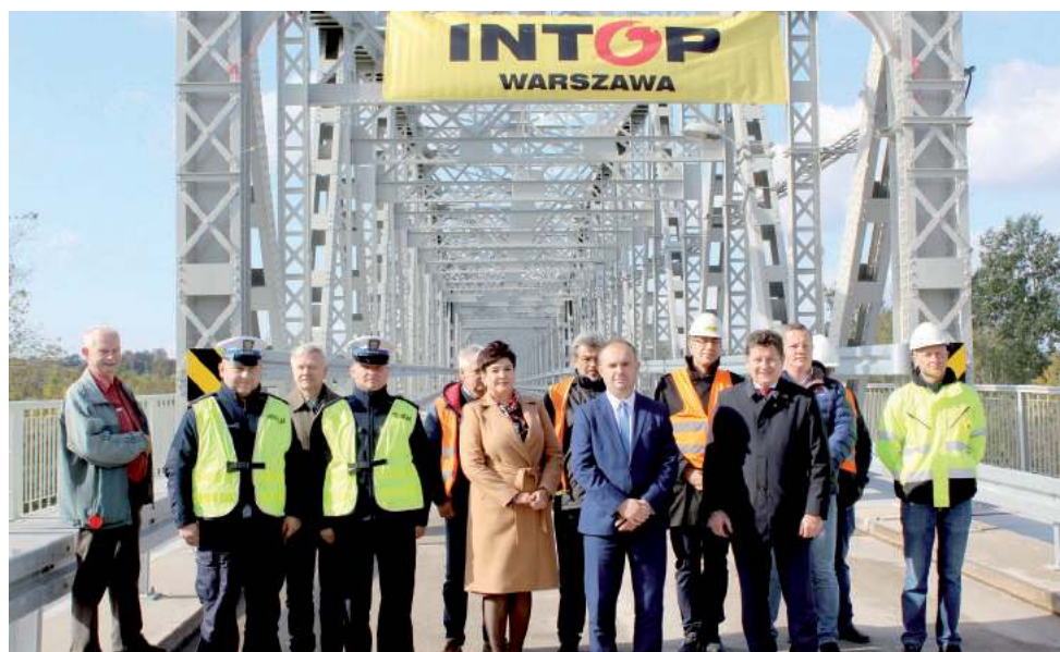
11 października most po remoncie został udostępniony dla ruchu samochodowego. W uroczystym otwarciu obiektu wzięli udział lokalni samorządowcy, przedstawiciele wykonawcy i Zarządu Dróg Wojewódzkich w Lublinie
