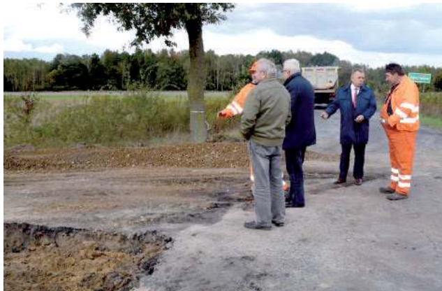
Władze gminy systematycznie omawiają z wykonawcą przeprowadzane przy budowie drogi prace
