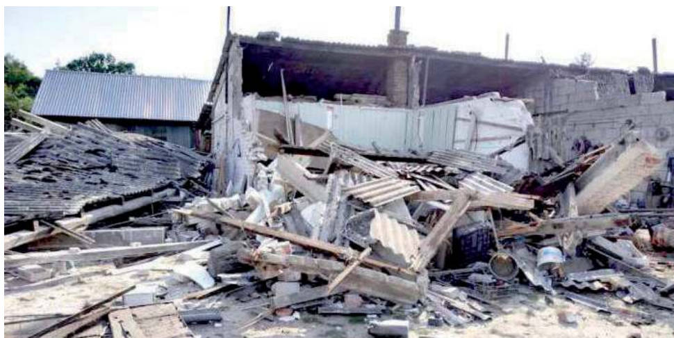
Taki widok zastał na miejscu właściciel zakładu kamieniarskiego 15 czerwca 2018 roku. Teraz oskarżony za dokonanie tych zniszczeń 36-letni mieszkaniec gminy Wąwolnica odpowie przed sądem
