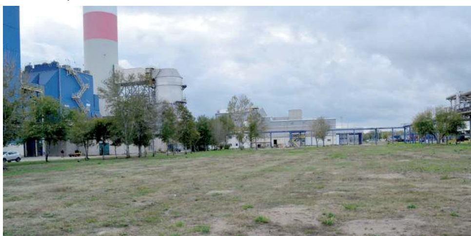
Do jesieni 2022 roku na tym pustym placu pośród działających pełną parą urządzeń ma powstać nowy blok węglowy. Budowa w środku funkcjonującego zakładu to nietatwe zadanie, wymagające dobrej współpracy między wykonawcą i inwestorem, o czym podczas konferencji przed uroczystością mówił Maciej Korniluk, wiceprezes Polimex Mostostal
