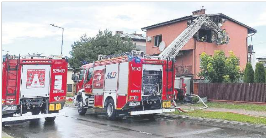
Ogień objął pierwsze piętro budynku mieszkalnego. Zgłoszenie o pożarze wpłynęło do służb w środę (2 września) około godz. 13:30 (fot. OSP KSRG Ryki)
