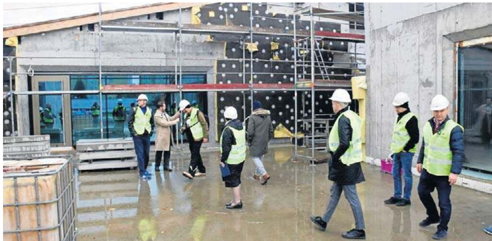
W styczniu 2022 roku, gdy przekazano plac budowy, budowa Mediateki miała potrwać około półtora roku. Wiadomo, że potrwa przynajmniej do marca 2026 roku
