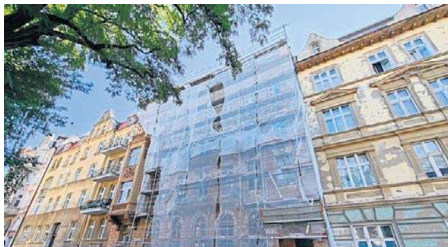
Remont tej pięknej, ciekawie zdobionej kamienicy przy ul. Poniatowskiego 5 właśnie się rozpoczął
