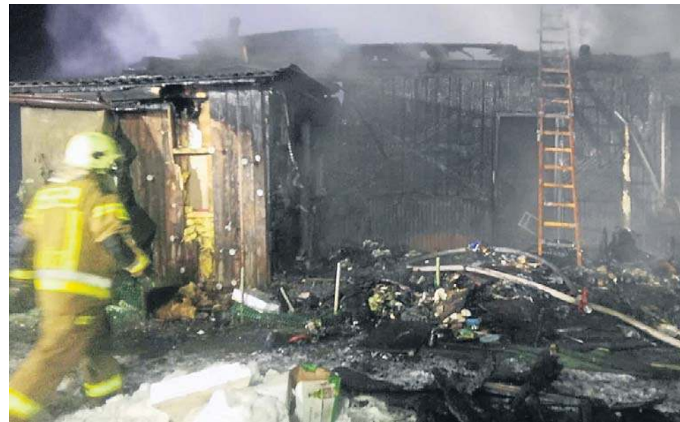
Mieszkańcy zostali bez dachu nad głową. Trwają zbiórki na odbudowę domu
