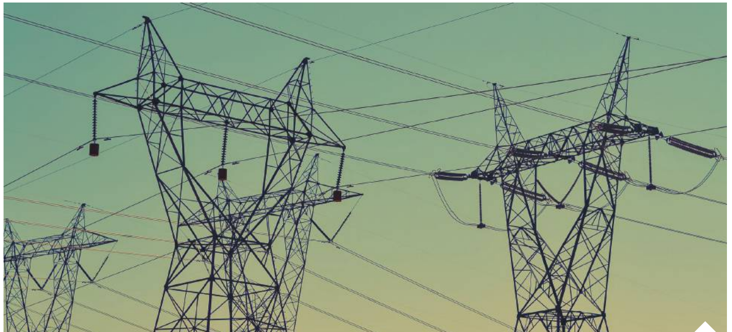
Zakaz eksportu energii elektrycznej z Ukrainy został zniesiony w kwietniu tego roku po wzmożeniu obrony przeciwlotniczej oraz zwiększeniu tempa odbudowy infrastruktury | fot. Pixabay/d
