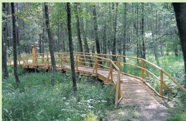
Pomost nad podmokłym terenem na trasie ścieżki
