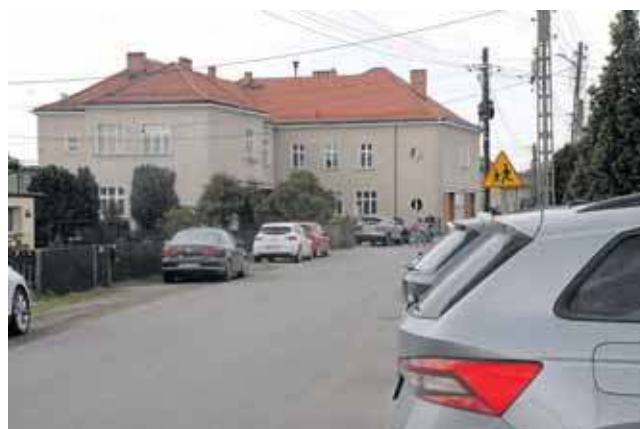
Jednym z kluczowych problemów wskazanych w interpelacji jest brak chodnika wzdłuż ul. Jagodowej. Droga ta jest wąska, a w godzinach dowozu i odbioru dzieci tworzą się zatory i niebezpieczne sytuacje
