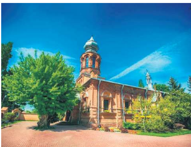
Radni przyznali 50 tys. zł dotacji na remont kościoła garnizonowego w Hrubieszowie.
