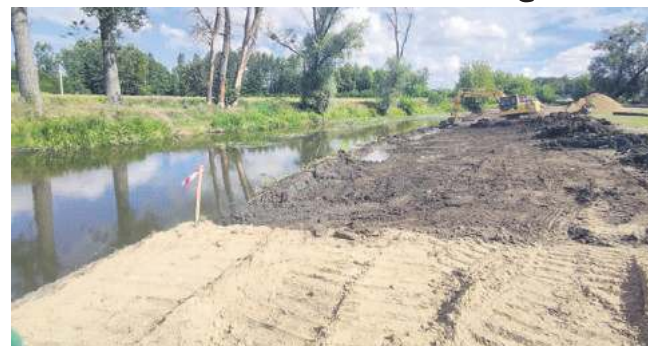
Roboty ziemne przy urządzeniu kąpieliska potrwać do końca sierpnia.
