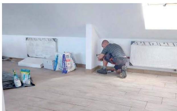
Finał prac na poddaszu, gdzie zostanie zamontowana wirtualna strzelnica
