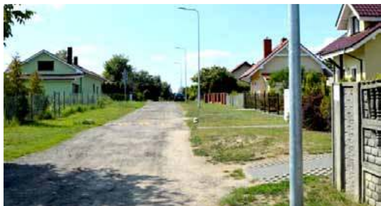
Na ulicy Chełmońskiego powstanie droga z kostki betonowej razem z chodnikiem
