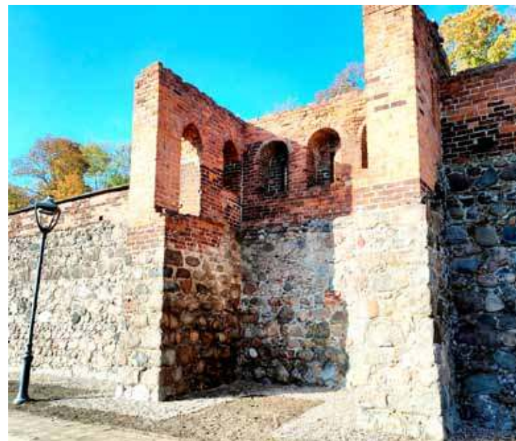
Zakończyła się odbudowa murów przy ulicy Klasztornej
