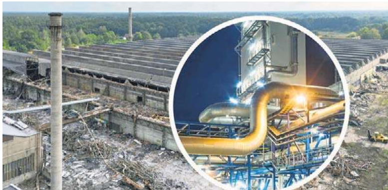
W miejscu po dawnej walcowni rur powstanie m.in. magazyn energii.
