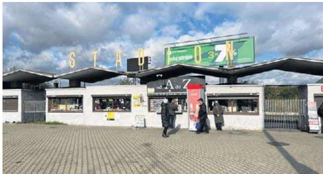
Budowa nowego węzła przesiadkowego w Będzinie oznacza jednocześnie wyburzenie unikatowych architektonicznie pawilonów łupinowych. A może da się je jeszcze uratować?
