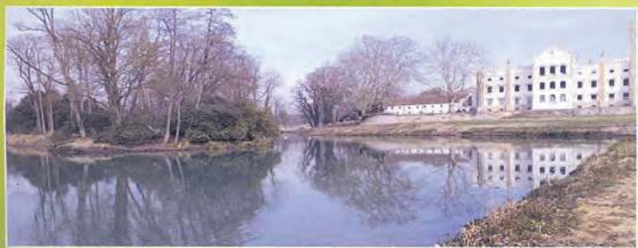
Pałac w trakcie renowacji
