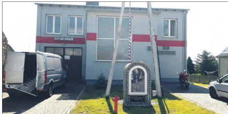
Tak wygląda zmodernizowana remiza
