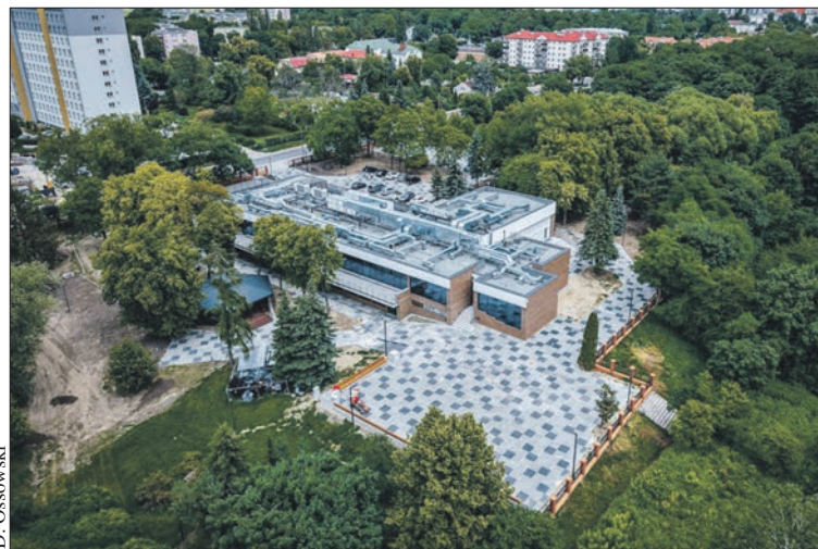
Dom Technika w pełnej krasie
