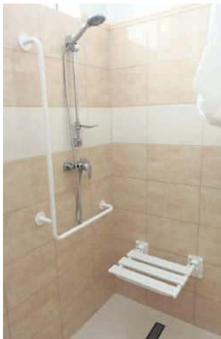
Łazienka w szkole w Prusach jest już w pełni dostosowana do potrzeb osób niepełnosprawnych
