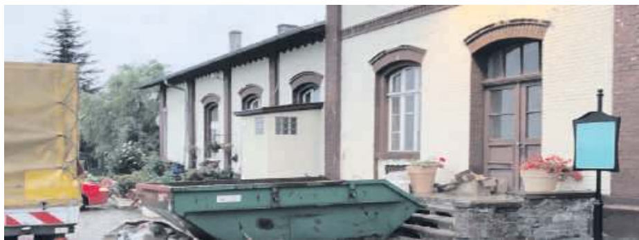
Trwa remont świetlicy wiejskiej w Boreczku
