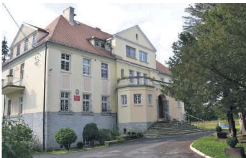
Pałac w Górcu, to okazały budynek osadzony na ponadhektarowej działce. Foto: Starostwo Powiatowe
