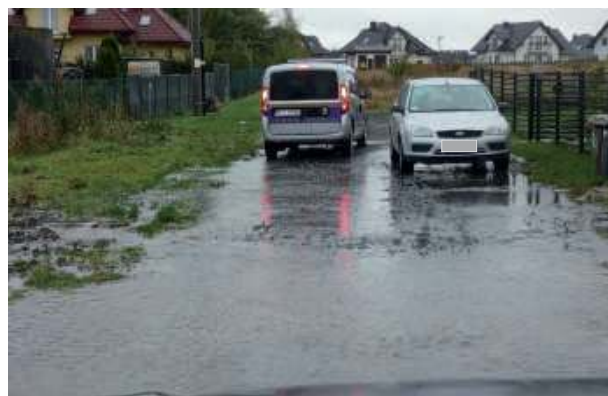
Problem podtopień przez zatkany lub niewydolny system drenażu pojawił się w Pławnej na tzw. nowym osiedlu
