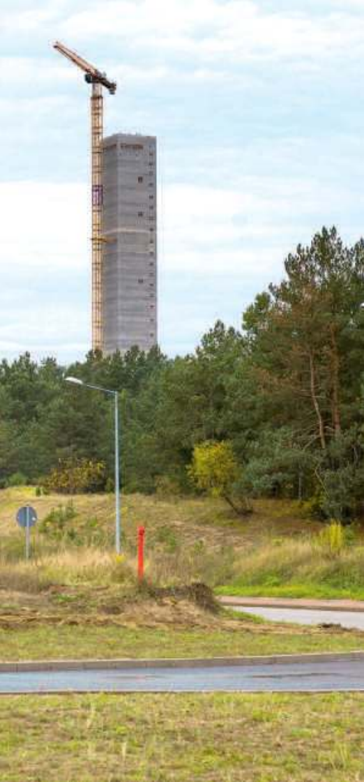
Tak budowa Elektrowni Ostrołęka C wyglądała w październiku 2020 r.
