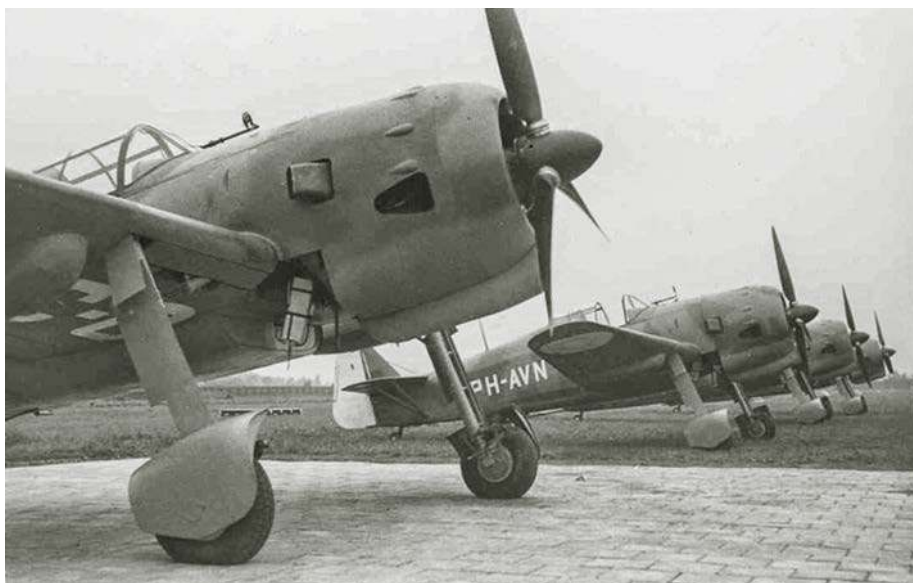
Stojące w rzędzie nowo wyprodukowane FK.58A. Doskonale widoczne szczegóły osłony silnika Gnome-Rhône 14N.
