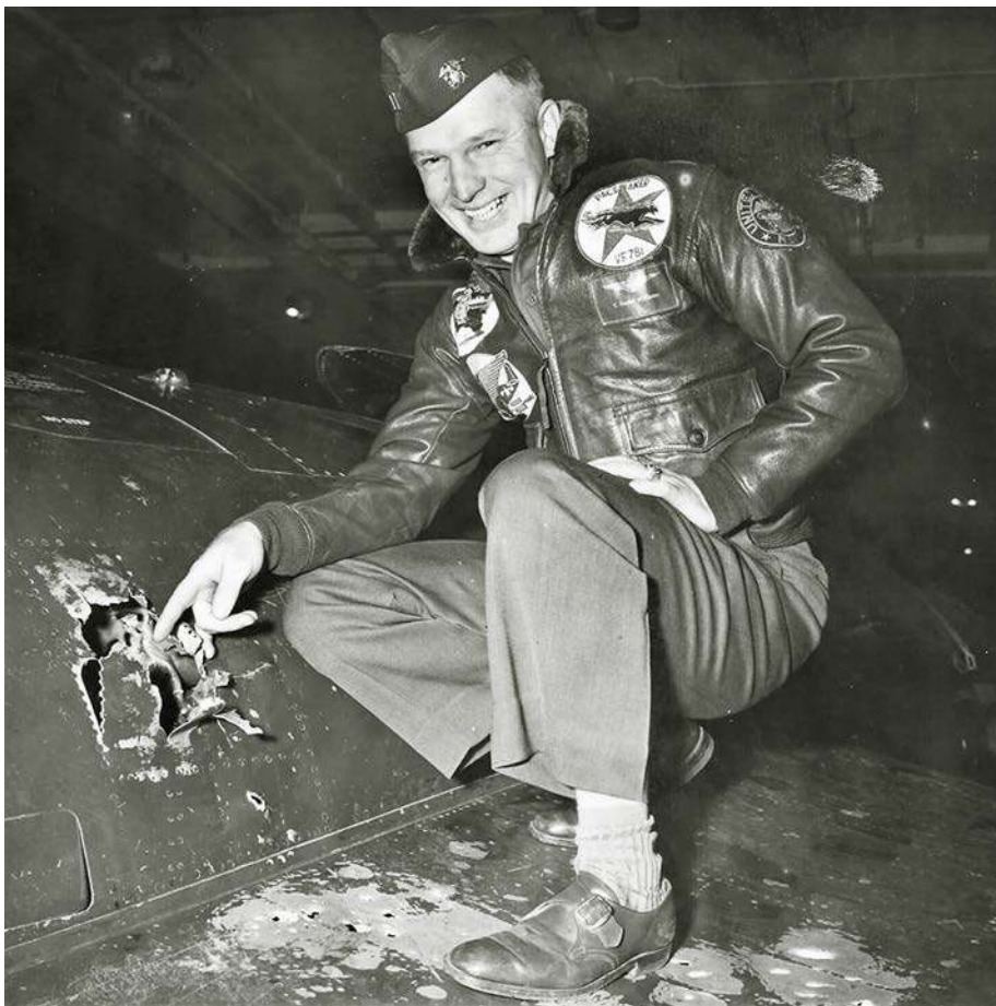
Lt. Williams wskazujący po powrocie z legendarnego starcia uszkodzenie swojego samolotu pociskiem kal. 37 mm wyrzucenym przez radzieckiego myśliwca. Uwagę zwraca duża liczba przebić pokrycia odłamków pocisku, których suma w licznych publikacjach uważana jest za liczbę przestrzelin.
